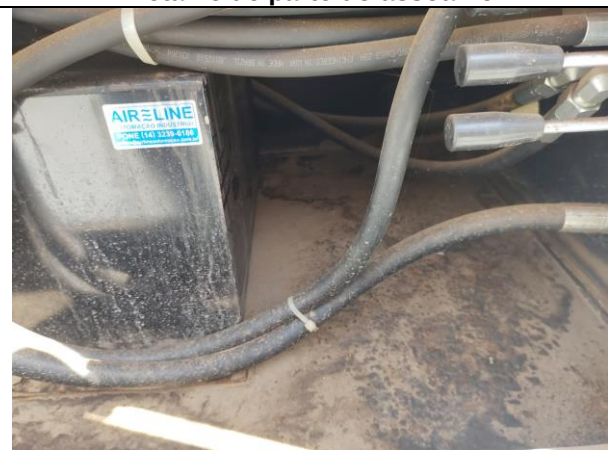
Parte interna do bagageiro do comando hidráulico
