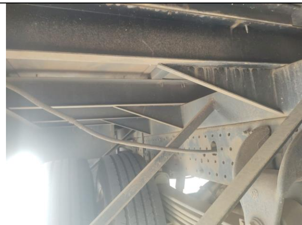
Detalhe de parte do assoalho
